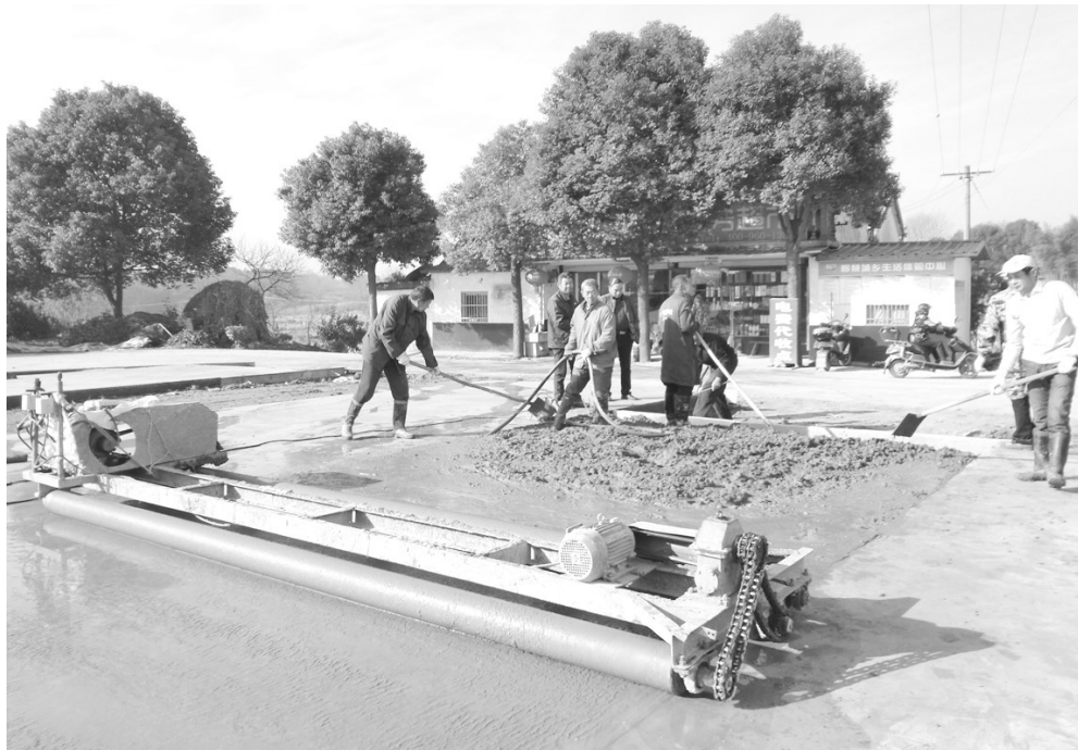
临近岁末,怀宁县金拱镇在注重抓好工程质量和施工安全的同时,倒排工期,对项目实施进度管理,加快推进美丽乡村建设。图为该镇黄马村美丽乡村中心村庄建设工地,工人们正在抓紧浇筑村民广场。钱续坤 张虎 摄
