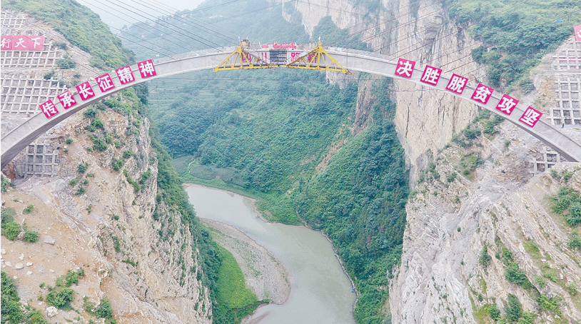
这是正在进行主拱圈合龙施工的鸡鸣三省大桥（7月7日无人机拍摄）。当日，位于川滇黔三省交界处的鸡鸣三省大桥主拱圈顺利合龙，标志大桥建设取得重大阶段性进展，为2019年底建成通车奠定了坚实基础。作为赤水河流域重要的渡改桥工程，该桥建成后将解决三省交界一带数十万群众的出行难题，有力助推乌蒙山区脱贫攻坚。 新华社记者 刘坤 摄
