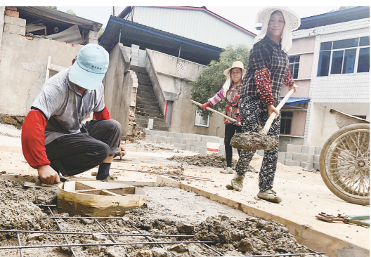
8月7日晚,工人师傅在怀宁县茶岭镇谭村村山组制作盖板。怀宁县紧紧围绕农村垃圾、污水处理、卫生改厕和村容村貌提升等重点,大力开展人居环境整治,切实改善农村环境风貌。
