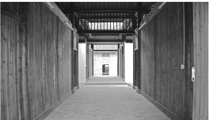
修缮后的张家药铺 记者 路欣 摄
