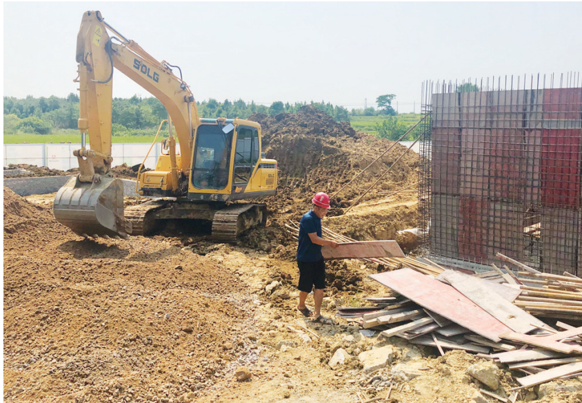
8月27日，工人在加紧施工。怀宁县雷埠乡争取项目资金700余万元建设污水处理厂，目前工程完成60%，预计9月底竣工，到时集镇区的生活污水将得到有效处理。 檀志扬 蒋善模 摄
