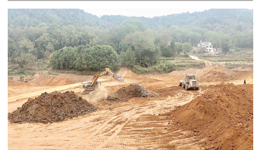
10月19日,大型机械在山区田间作业。怀宁县石镜乡石镜社区有近百亩山田因地势高低不平、田块面积较小无法进行机器作业,近期,该社区引进社会资本对小田进行大田化改造,并做好机耕道、沟路等基础设施建设,将撂荒的土地变成能排能灌、旱涝保收、适宜机械化耕作的基本农田。通讯员 檀志扬 查显峰 摄
