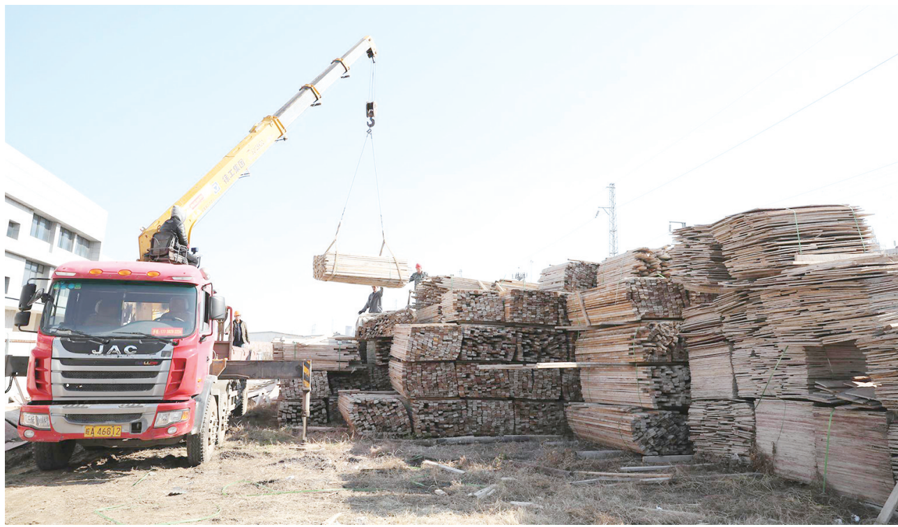
2019年12月27日,宜秀经济开发区工作人员对宁安城际铁路光彩段两侧违章建筑组织强制拆除。 记者 路欣 通讯员 龙开颜 摄
