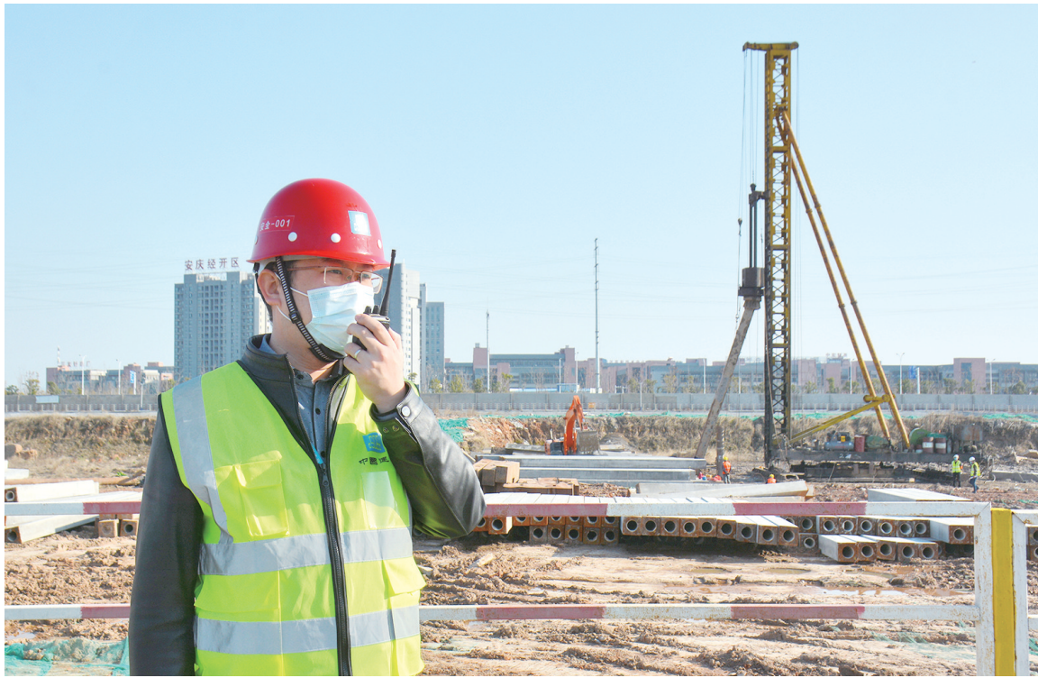
2月20日,安庆经开区段山还建点工程施工现场。记者 路欣 摄
