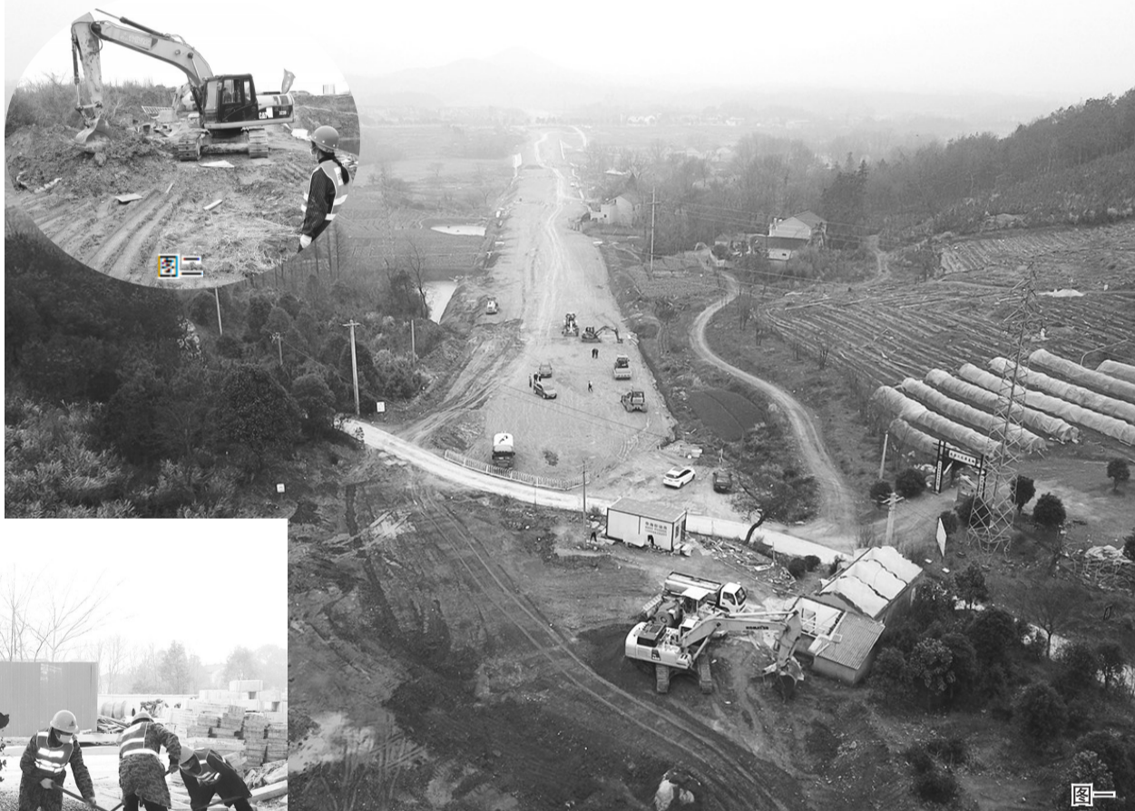
图一 路基工区复工 图二 预制场施工 图三 整修便道
