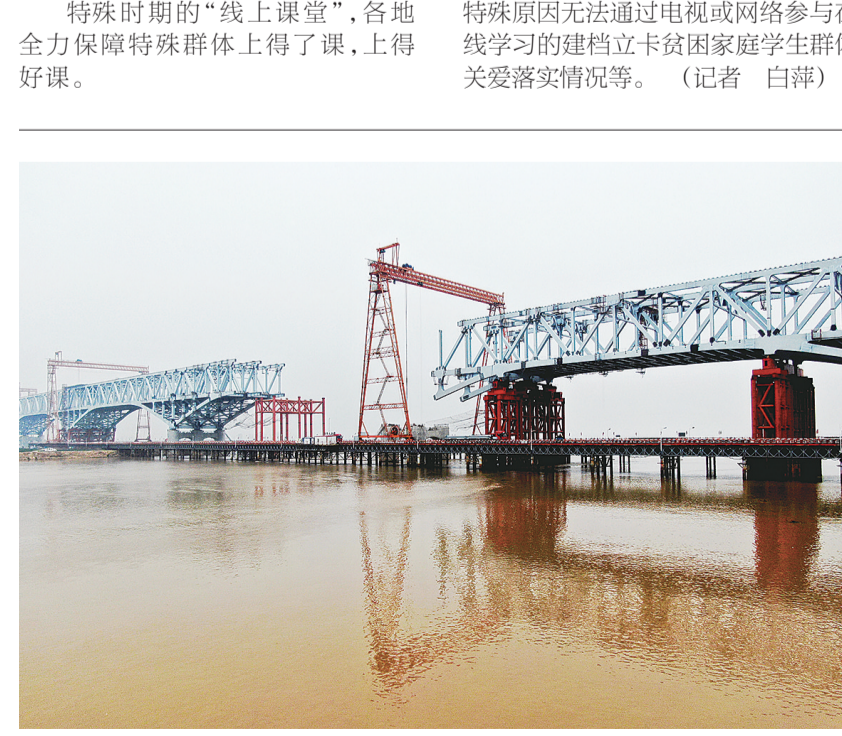
近日，国家重点工程——郑(州)济(南)高速铁路郑州黄河特大桥建设工程有序复工。由中铁大桥局承建的郑济高速铁路郑州黄河特大桥主桥及南引桥全长4377米，采用公路、铁路上下层合建的布置形式，设计4线铁路、6车道快速公路。 新华社记者 朱祥 摄
