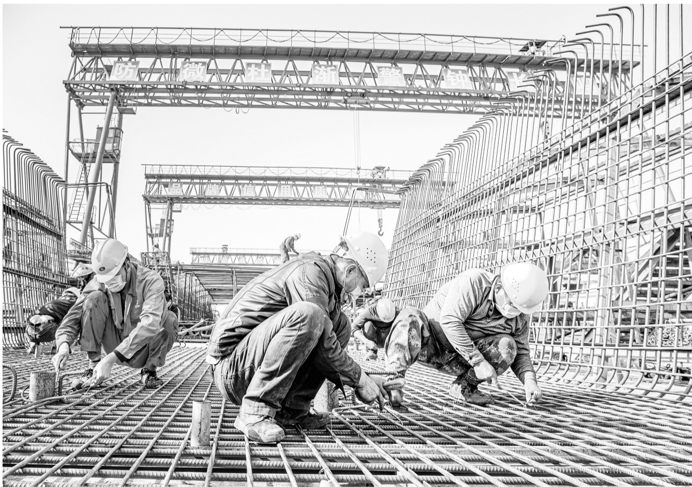
3月5日，在中铁上海工程局第三工程有限公司安九高铁潜山制梁场，工人们正在紧张开展扎绑钢筋作业。安九高铁潜山段于3月2日正式复工。复工以来，该工程一手抓疫情防控，一手抓项目建设，所有工人上岗前进行疫情防控安全培训，施工现场封闭式管理，并采取一日两次测体温、现场消杀等措施，工程正处于稳步推进之中。据悉，安九高铁项目将于2022年底全面建成通车。
