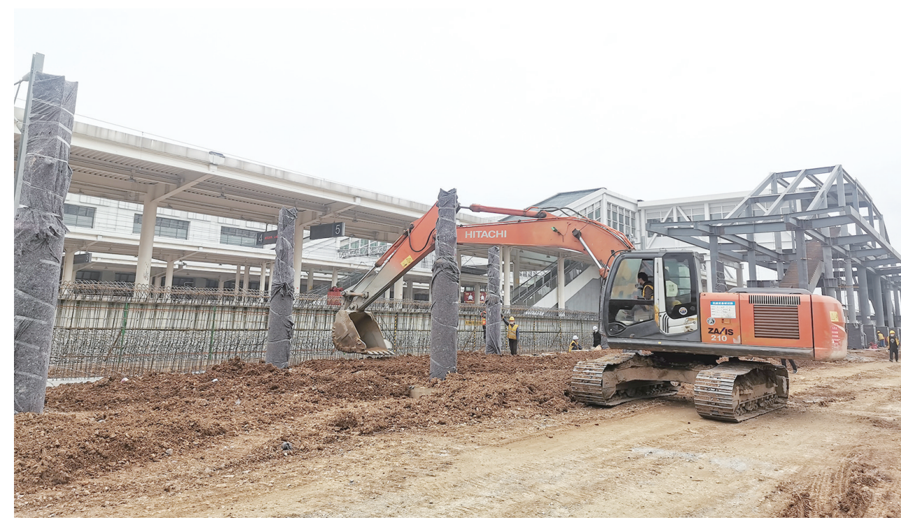
3月8日,安九铁路合安联络线安庆站改工程现场。雷琳琳 摄
