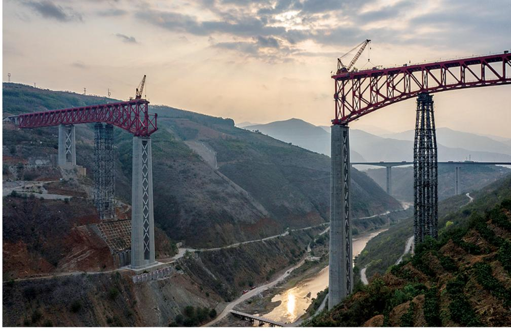
4月8日清晨,工人在中老铁路元江特大桥上进行钢桁梁架设作业(无人机照片)。
