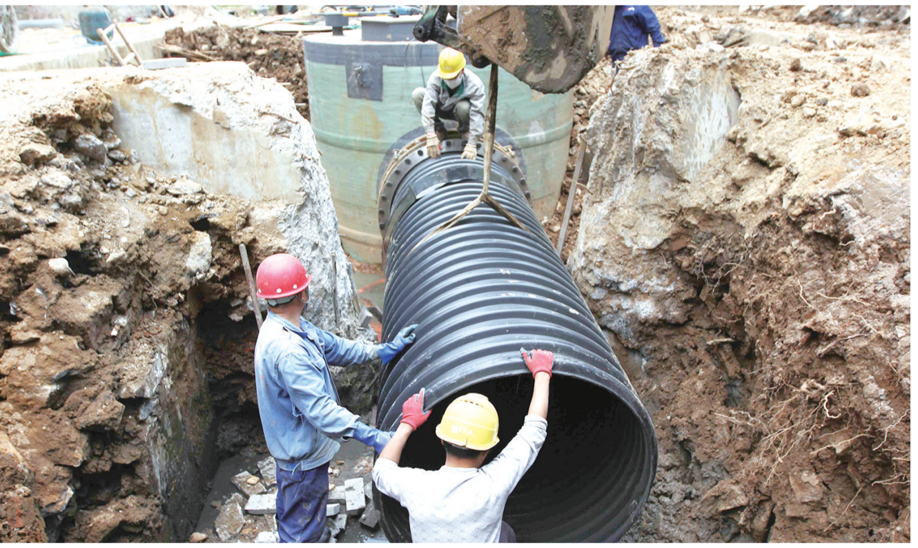
工人们正在安装泵站的雨水进水和出水管。徐火炬 摄
