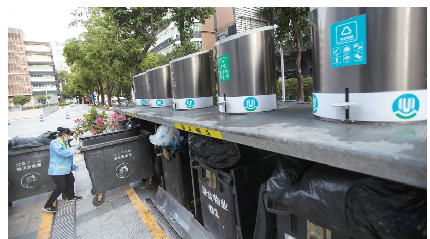
4月21日,清洁工人在深圳市福田区清运地理式垃圾桶。近日,一批具有消毒防疫功能的地理式垃圾桶在深圳启用。据介绍,地理式垃圾桶的收集桶位于地面以下,清运时才露出地面,桶内垃圾满溢可自动报警,通知环卫工人清运。据介绍,该类地理式垃圾桶配备排水系统与灭火系统,并可在地下密闭空间进行自动消毒。 新华社记者 卢焯 摄
