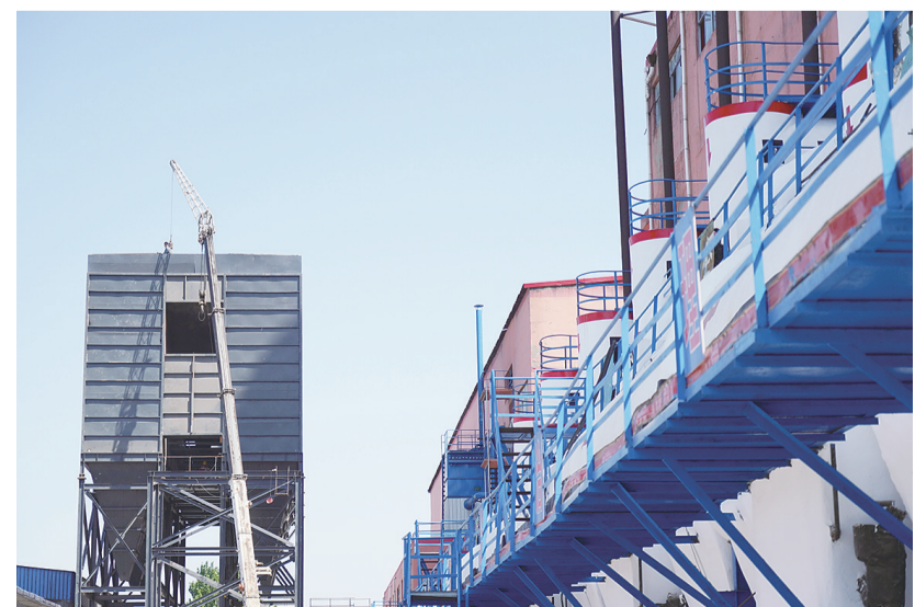
这是位于河北省沙河市的河北德金玻璃有限公司烟气净化深度治理塔建设现场(4月23日摄)。2019年起,有“中国玻璃城”美誉的河北沙河市启动了“烟羽消白”工程,先后投入20亿元对在产玻璃生产线实施超低排放改造,并结合提升厂区环境、优化产能等措施,削减粉尘、二氧化硫、氮氧化物等污染物排放,推进大气污染防治。 新华社记者 牟宇 摄
