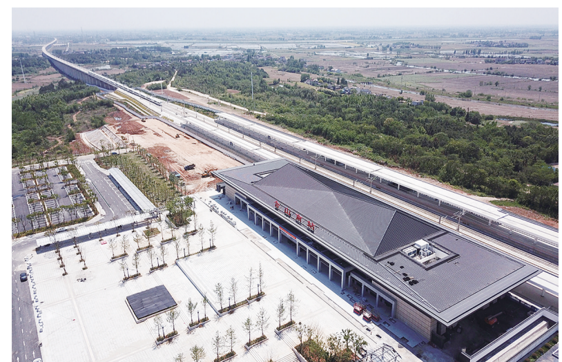
4月28日，一辆联调联试列车经过中铁四局承建的商合杭高铁合山南站。当日，商合杭高铁合肥至芜湖北段站房及生产生活房屋开始接受静态验收，各项施工进入最后冲刺阶段。 新华社记者 刘军喜 摄
