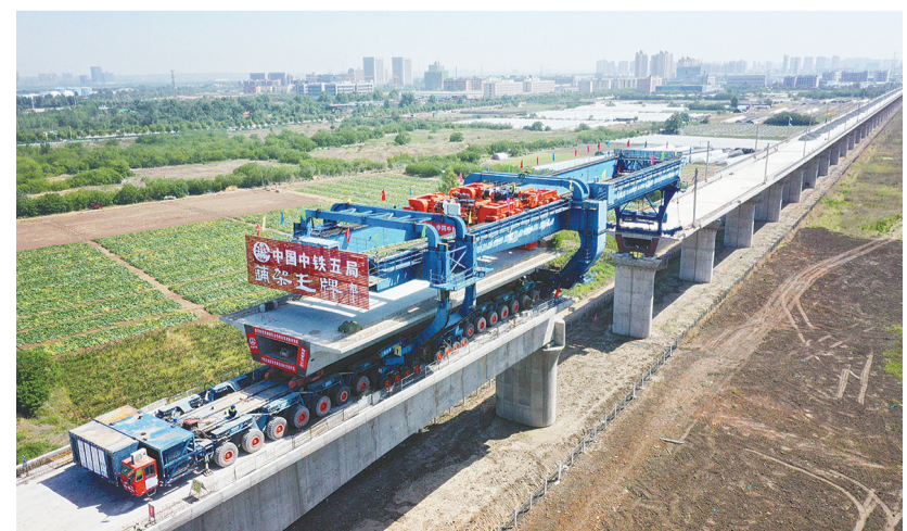
5月10日,工人在银西高铁咸阳渭河特大桥上架设全线最后一根箱梁。当日,随着中铁五局建设者将最后一根箱梁架设在银(川)西(安)高铁陕西咸阳渭河特大桥227号至226号墩上,标志着银西高铁全线箱梁架设任务完成。银西高铁是国家中长期铁路网规划中“八纵八横”高铁网包(银)海通道的重要组成部分,预计2020年底开通。新华社记者 刘潇 摄
