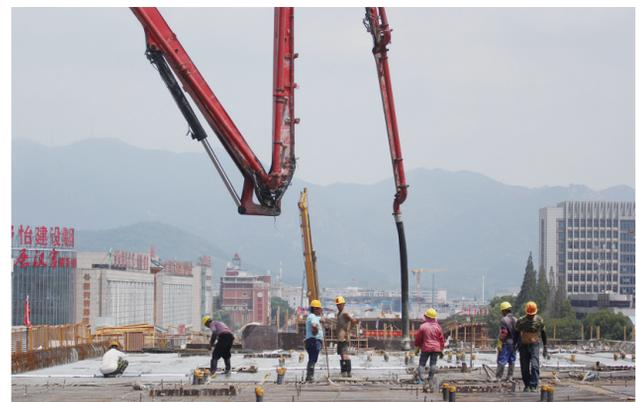
8月5日,中兴大道快速化改造项目工程施工现场,工人正在浇筑顶板。截至目前,中兴大道桩基已基本完成,承台累计完成224座,完成占比84.8%;墩柱累计完成201座,完成占比76.1%;道路碎石完成75%,水稳完成72%,沥青完成70%。
