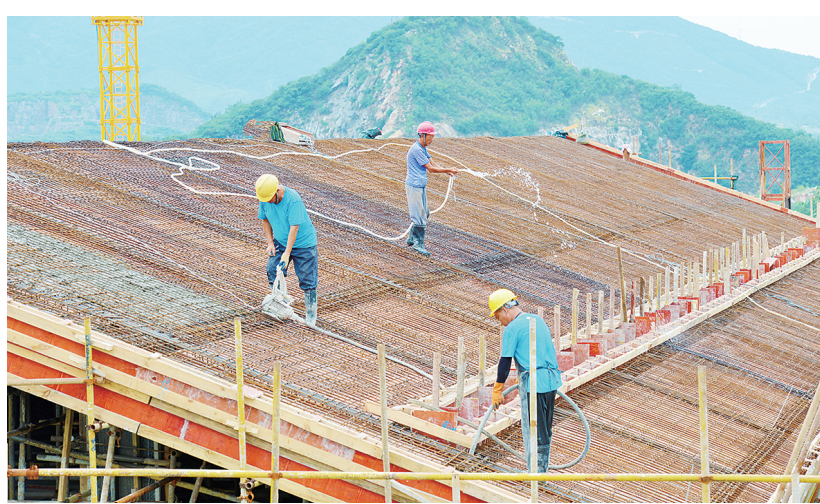
8月7日,安庆市委党校改扩建工程项目施工现场,建设者绑扎板面钢筋。近日,我市持续高温,当日室外温度达35摄氏度,各建筑工地仍顶酷暑抢进度。据悉,市委党校改扩建工程将于明年4月份完工。 记者 路欣 通讯员 谈天 摄
