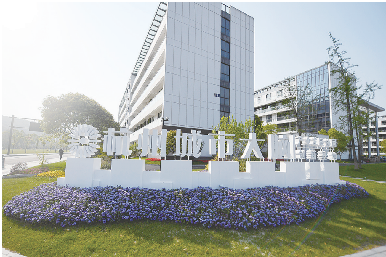
杭州城市大脑产业发展协同创新基地外景，杭州城市大脑运营指挥中心坐落在基地中。新华社记者 黄宗治 摄
