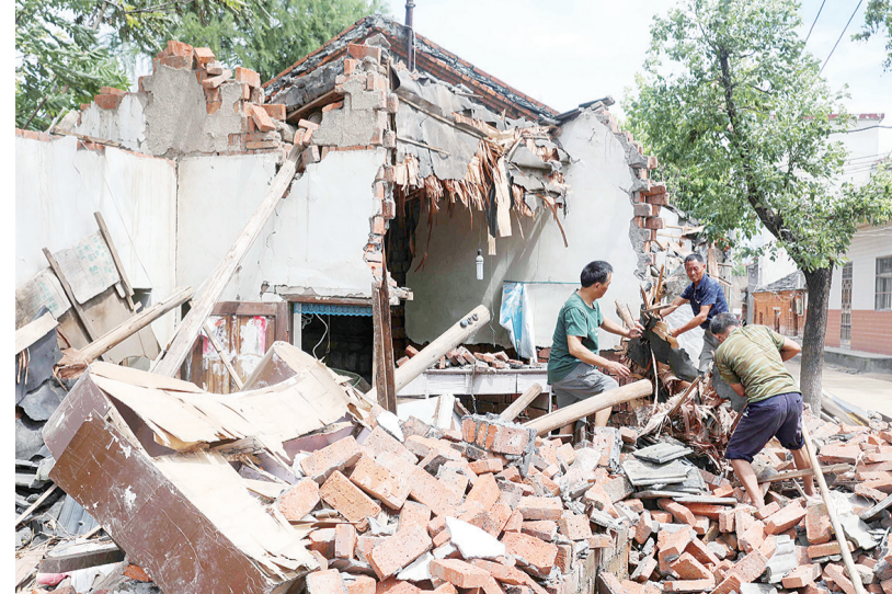
巢湖市银屏镇钓鱼村组织村民整理被水毁的房屋(8月14日摄)。记者从安徽省防汛抗旱指挥部获悉,目前巢湖水位已落至保证水位以下,呈持续缓退状态。安徽省巢湖市银屏镇积极开展抢修水毁基础设施等灾后重建工作,因洪灾转移的村民陆续返家,灾后重建工作有序进行。 新华社记者 曹力 摄
