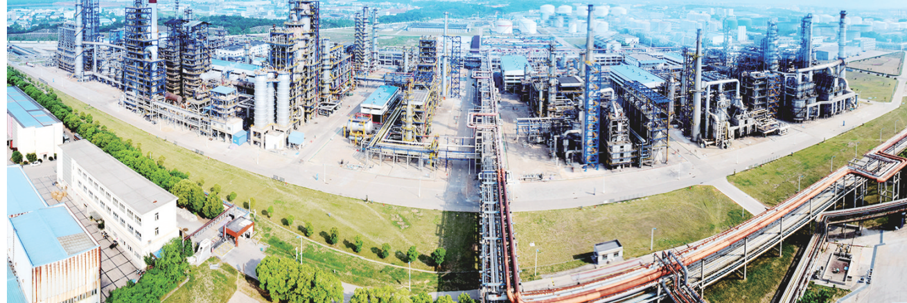
安庆石化800万吨/年炼化一体化新区现场。炼油转化结构调整项目实施后,安庆石化由燃料型炼厂向化工型炼厂转型。
