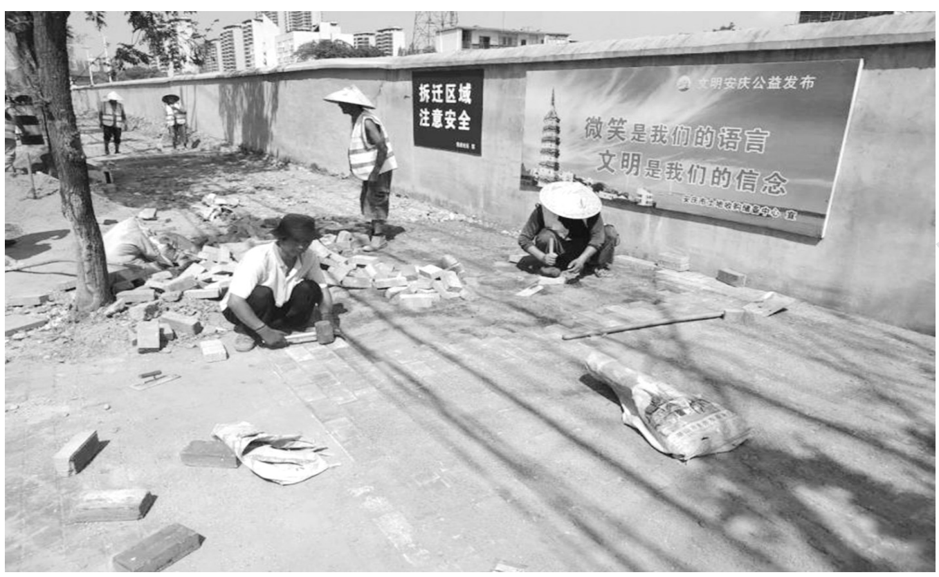
8月27日,工人们正在修整破损的路面。连日来,迎江区市政环卫管理中心所有机关人员下沉到督察大队各中队所对应的3个环作业片区,明确分工,制定责任清单,具体到责任领导、责任人、责任片区,进行全方位全覆盖督察巡查。组织人员对辖区各层面作业进行全方面巡查,修复吕八街、杨家山、建设路、锡麟街与孝肃路交叉口破损路面约39平方米,调整路沿石6米,砖面调整11平方米;疏通人民路步行街排水沟1处。 通讯员 何芳 摄
