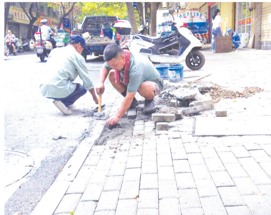
对破损路面进行修补 何芳 摄
