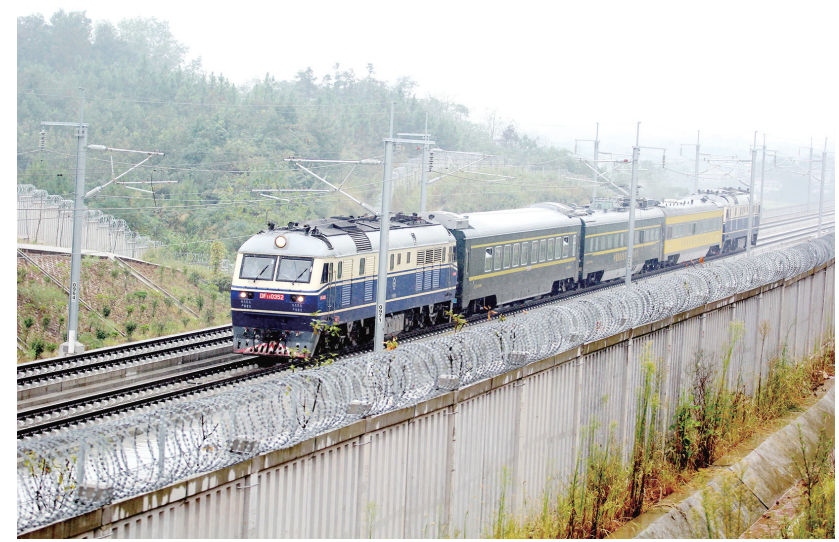
9月10日13时26分,合安高铁工程轨道检测列车途经由中铁北京工程局承建的桐城段。
