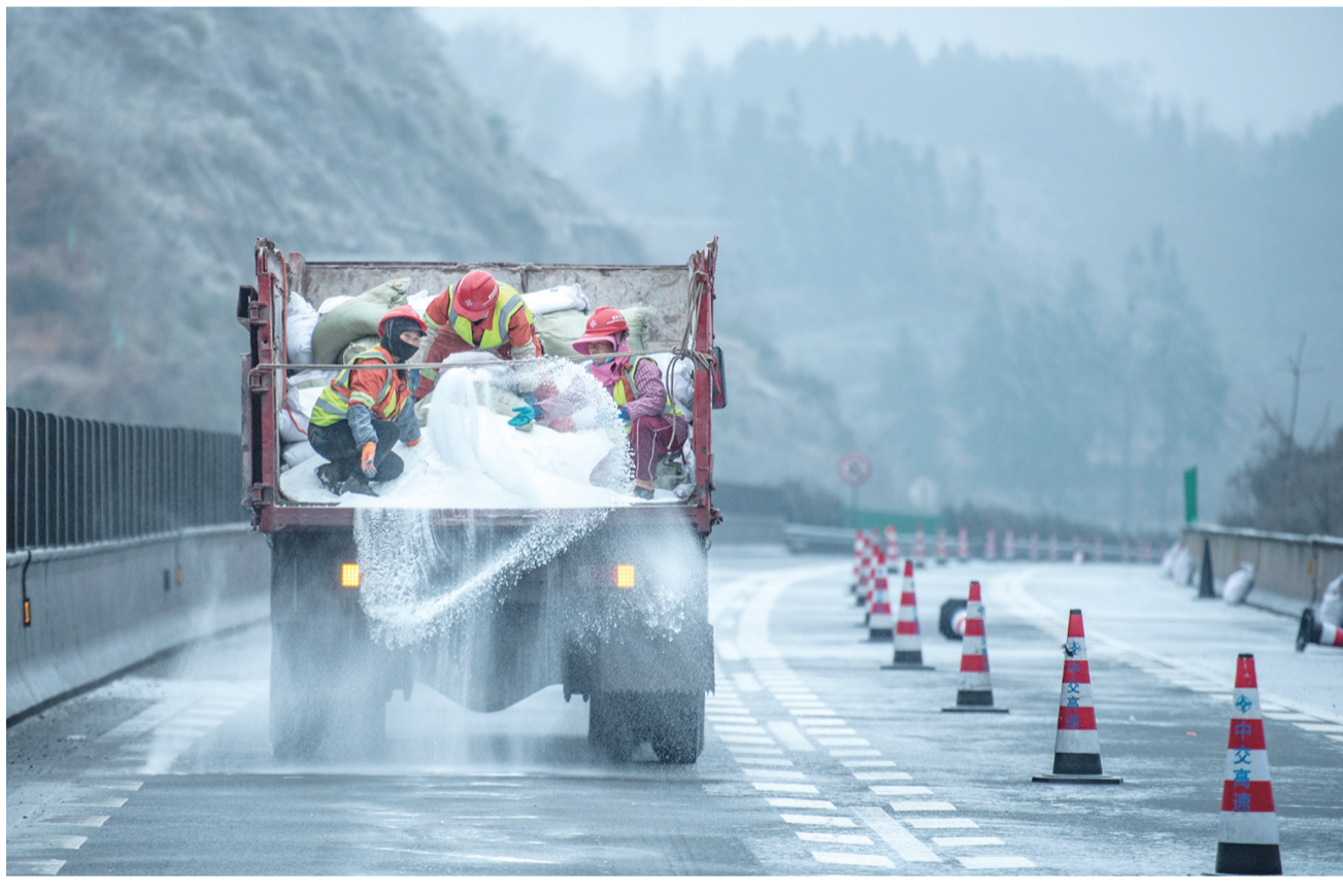
1月7日,工作人员在开展撒盐除冰作业。
