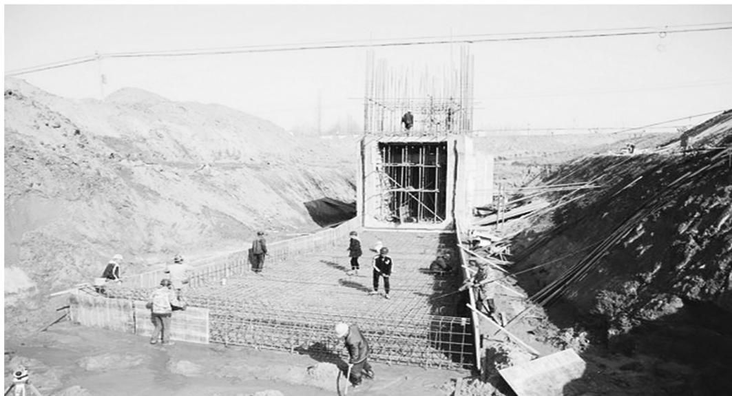
1月10日,宿松县二郎河流域治理工程松兹排涝二站施工现场,工人们正加紧对防洪闸段进行施工,预计春节前将完成闸门安装等各项事宜,确保安全度汛。
