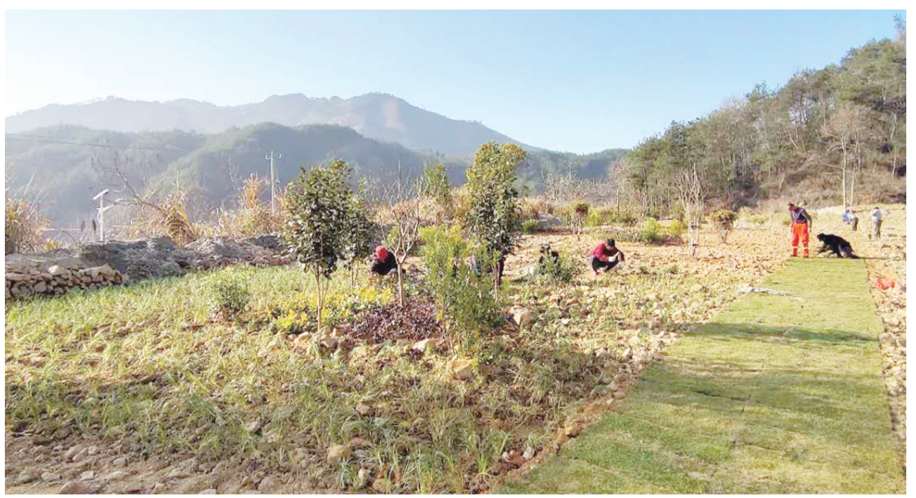
太湖牛镇镇龙湾村晋北矿山治理现场,工人们正在铺设草坪。通讯员 摄
