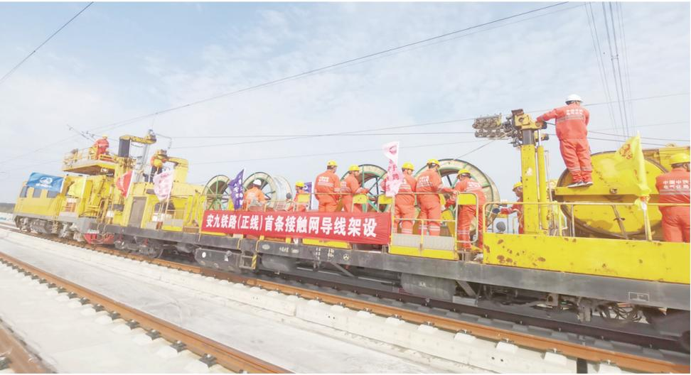
安九铁路(正线)首条接触网导线架设现场。
