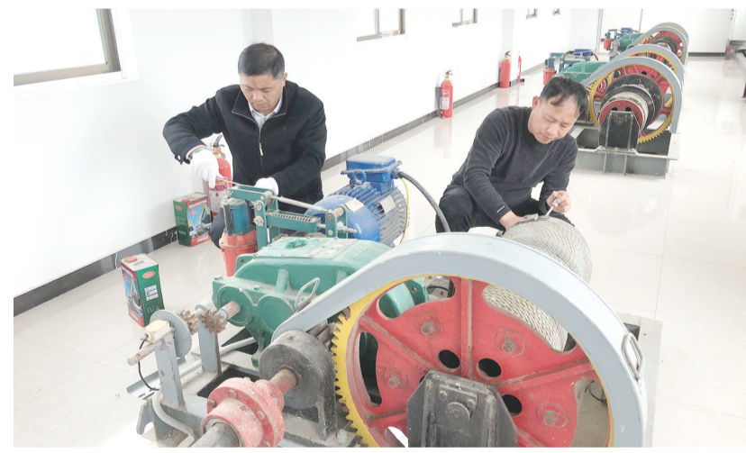
4月7日,怀宁县三桥镇水利站工作人员在解放闸加注润滑油和检修启闭设备。为应对可能出现的旱汛、大洪水,怀宁县各乡镇及相关单位从早、从严、从实做好各项防汛准备工作,推动防汛备汛各项工作落深落实。 通讯员 檀志扬 王敏 摄
