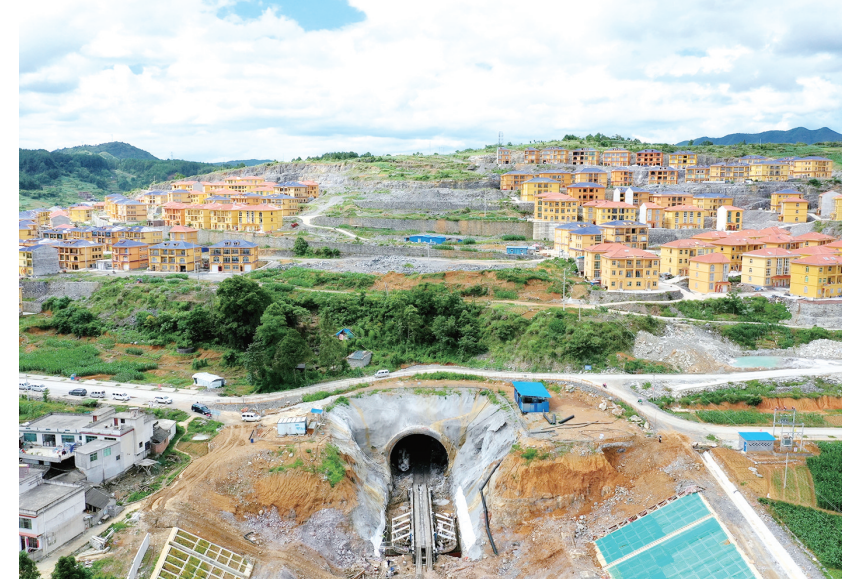
这是鄂家寨隧道外景。6月14日,贵南高铁鄂家寨隧道顺利贯通,该隧道地处贵州省独山县境内,全长1670米。贵南高铁设计时速350千米,是我国“八纵八横”高速铁路主通道乌东至海口通道的首要组成部分。 新华社记者 刘建雄
