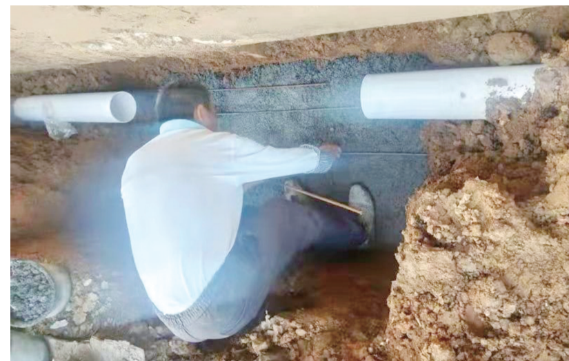
秋高气爽,在望江县凉泉集镇污水管网铺设现场,施工工人正在开挖沟道、安装管道。凉泉乡将户管支管接入主管网。工程总造价约1200多万元,建成后将实现污水管网户户通,集镇上1300多户居民的生活污水将得到全面收集和处理,改善集镇的人居环境。目前已完成总工程量的80%,计划今年11月底完工。(通讯员 周珺 摄)
