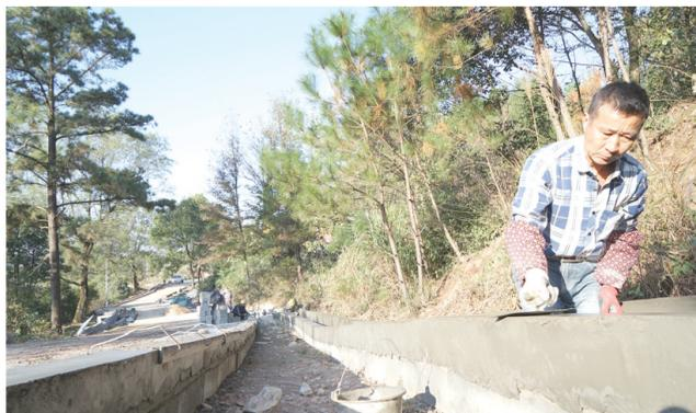
11月10日,工人在怀宁县茶岭镇茶岭村倪冲山下砌水沟。倪冲山下居住了不少村民,为确保群众生命财产安全,该村将靠山一侧砌成200多米长水沟,避免造成雨水冲击道路和房屋,解除了安全隐患。(通讯员 檀志扬 曹晓春 摄)
