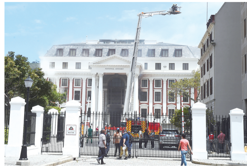
1月2日,消防员在南非开普敦的议会建筑起火现场工作。南非议会2日晚发表声明说,位于立法首都开普敦的议会主要建筑在当天清晨发生的火灾中受损严重,消防员已控制多处火势但尚未完全扑灭大火。新华社发(哈比索·姆卡贝拉 摄)
