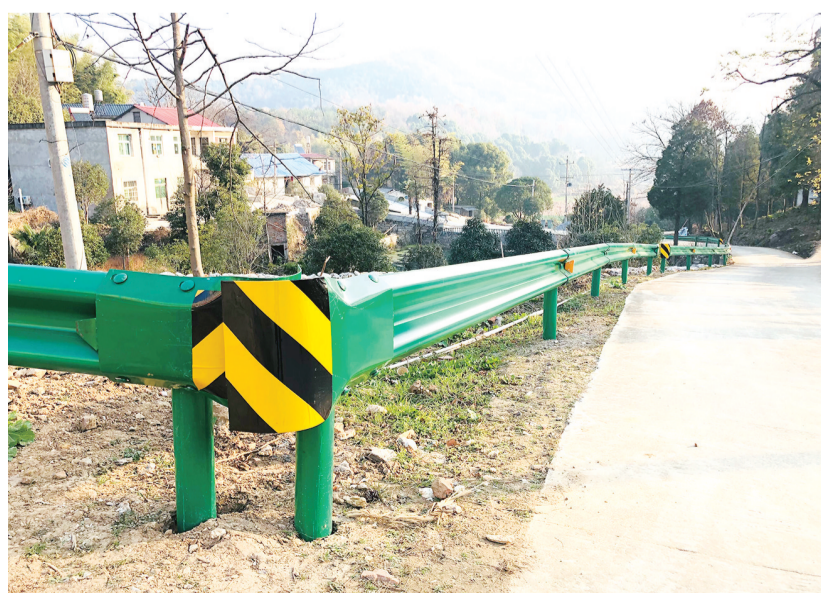
怀宁县石镜乡属山区乡镇,山道弯多,存在一定的安全隐患,为保证村民的出行安全,该乡投资45万元,对14条、长度约2700米存在安全隐患的山道,全部安装了波形防撞护栏和设置震荡标线。
