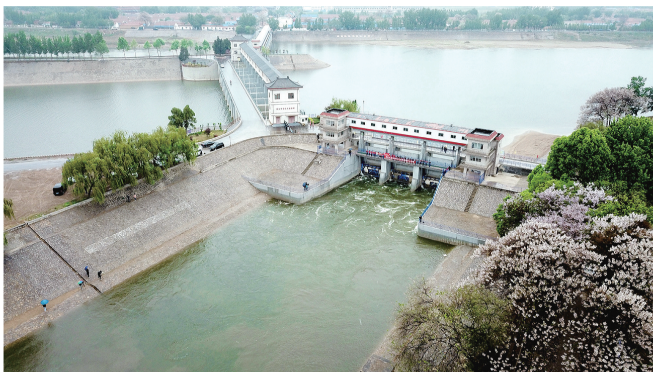
4月28日,山东省德州市四女寺枢纽南运河节制闸开启,对京杭大运河全线贯通补水(无人机照片)。
