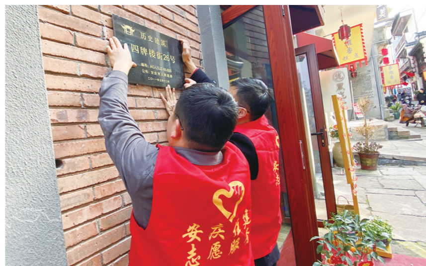
机关党员为历史建筑更换名牌。通讯员 郑莎 摄
