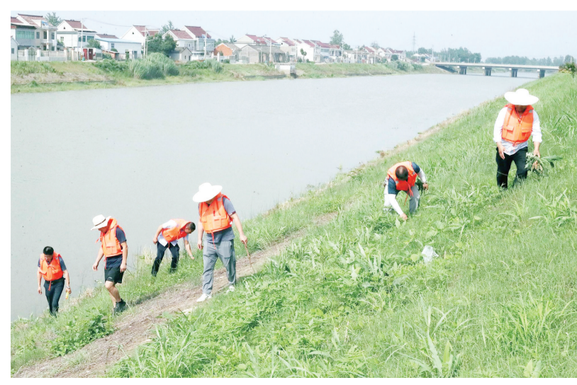
6月13日,望江县赛口镇南墩村民兵沿着同庆圩堤坝检查堤面情况。入汛后,该镇组织民兵在圩口堤坝沿线待命并每日开展巡堤,随时做好抢险准备,确保汛期安澜。 全媒体记者 储永志 通讯员 檀竹兵 摄
