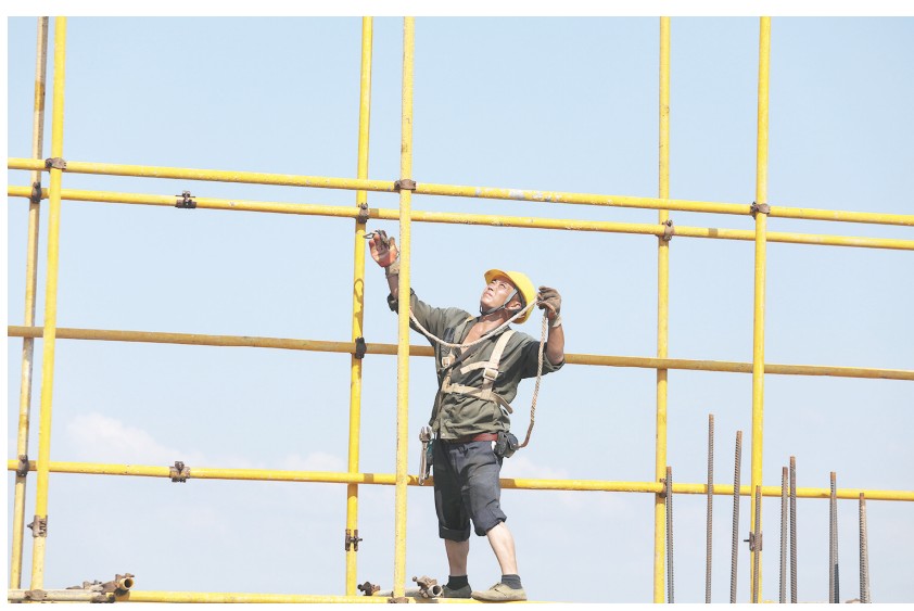
林南贵站在钢管上搭设脚手架。 全媒体记者 徐火炬 摄
