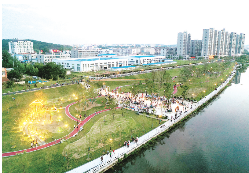
近日,潜山市源潭镇鲁坦河滨河公园暨岩壁生态修复工程竣工开放。该公园占地面积62000平方米,涵园林景观、堤防防汛道路、游园步道、特色植被、生态护坡等为一体,融合鲁坦河山水自然景观,有效改善镇区生态环境,提升城镇品位。(通讯员 李鸿志 摄)
