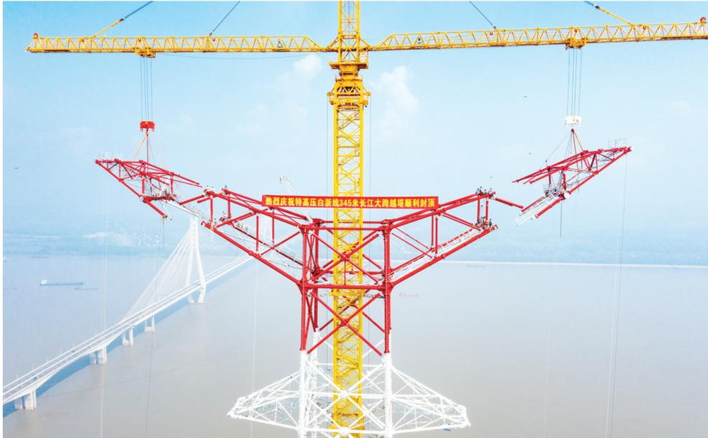
8月1日,安徽送变电工程有限公司施工人员在池州长江大跨越南岸跨越塔封顶施工现场作业(无人机照片)。
