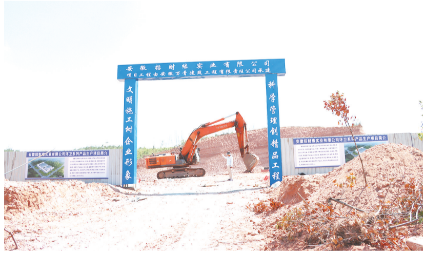
8月21日,潜山市源潭镇4个重点项目集中开工,总投资达21亿元,项目涵盖制刷和机电等领域。(通讯员 李鸿志 摄)
