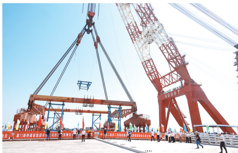
9月12日拍摄的厦门翔安大桥主桥成功合龙现场。当日,福建省厦门市第二东通道——翔安大桥主桥成功合龙。翔安大桥全长约12公里,其中跨海桥梁长约4.5公里,设计时速80公里。新华社发
