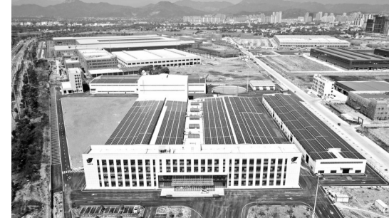
图五: 厂区内光伏发电板
