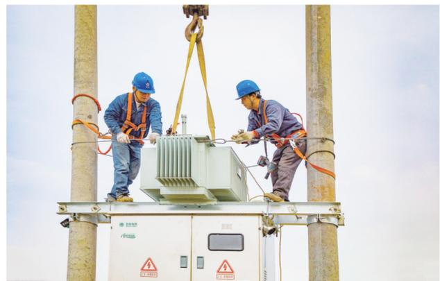
11月14日中午,国网桐城供电公司员工正在对已经负荷重载的10千伏狮山12线双联支线进行升级改造。天气转冷,用电高峰即将到来,该公司提前部署,全力保障降温天气线路安全可靠运行。
