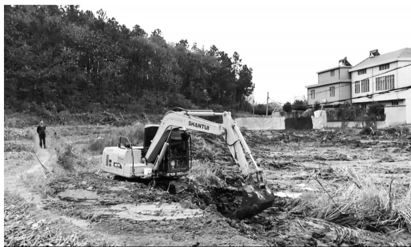
桐城市龙眼街道长生社区来源村民组翻修当家塘,工程完工后,可保障80亩农田灌溉,让周边127户426人受益;并在改善群众生产生活条件的同时,美化乡村环境,提升群众幸福感。全媒体记者 黄有安 通讯员 周佳林 摄
