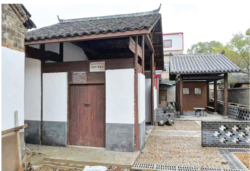
经过修复的砂岗施家老屋 通讯员 吴春富 摄
