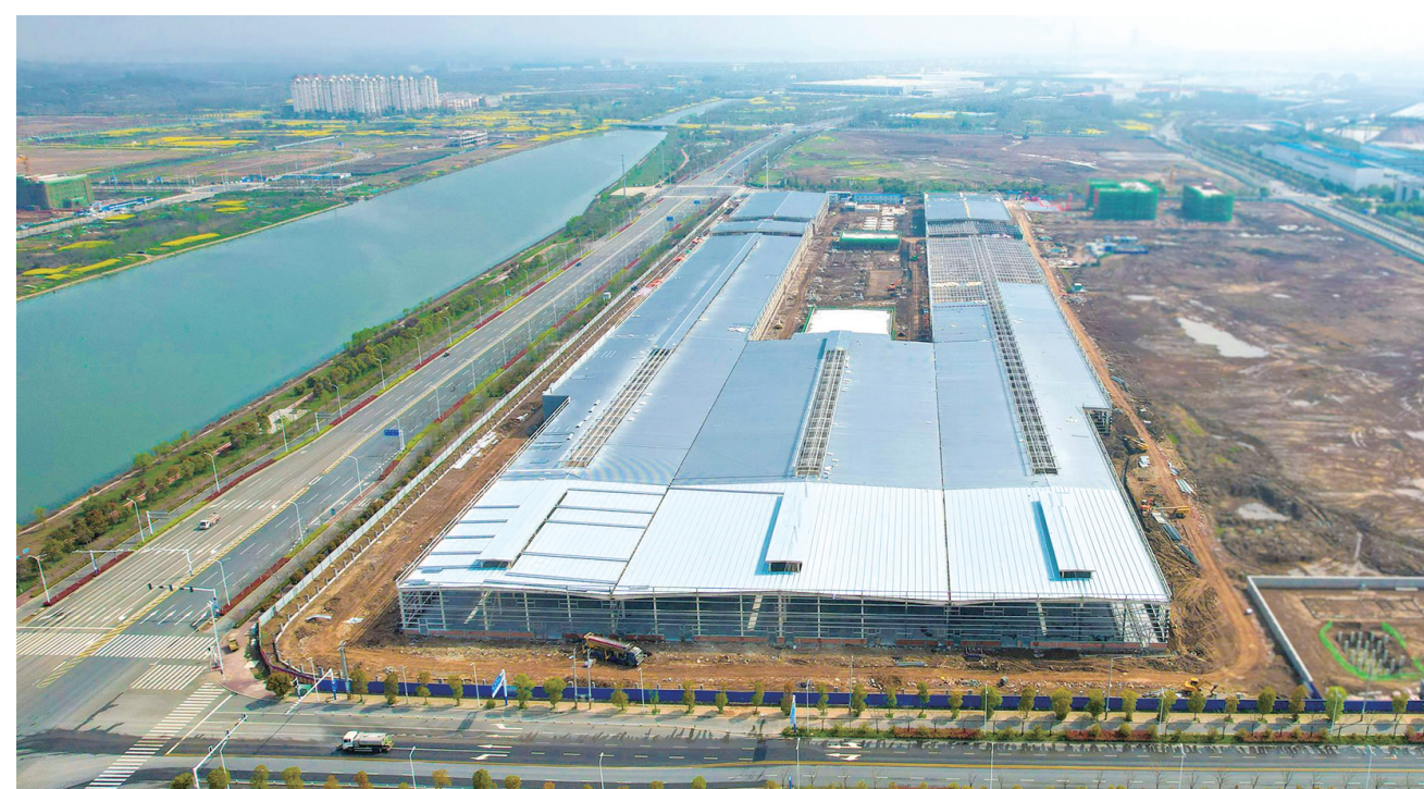
3月27日,衡川锂离子电池隔膜生产项目封顶。
