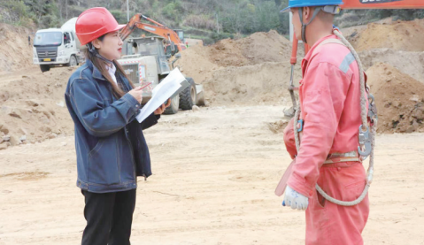
翟卫芳在电力施工现场检查施工情况。 通讯员 刘灿 摄
